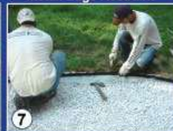
Install Edge Restraint
