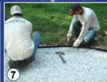
Install Edge Restraint
